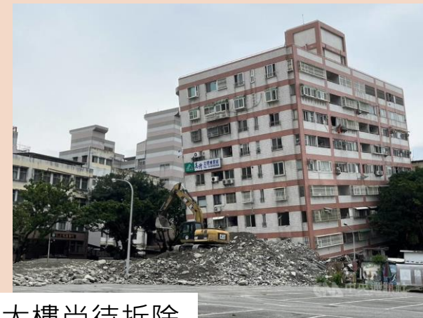
富凱大飯店、統帥大樓尚待拆除
