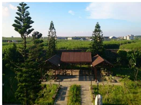
七美南嶼城修繕工程
