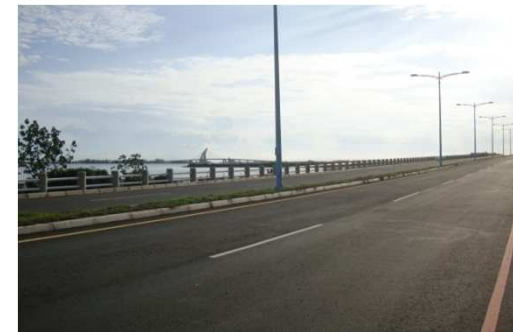
環灣道路8K+100~9K+100段 拓寬及沿線景觀設施工程
