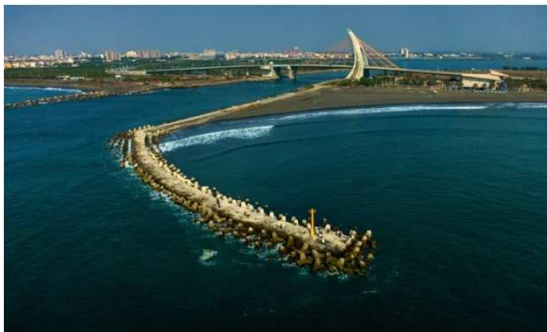
大鵬灣潮口導流堤及青洲岬灣 海岸保護第一標工程
