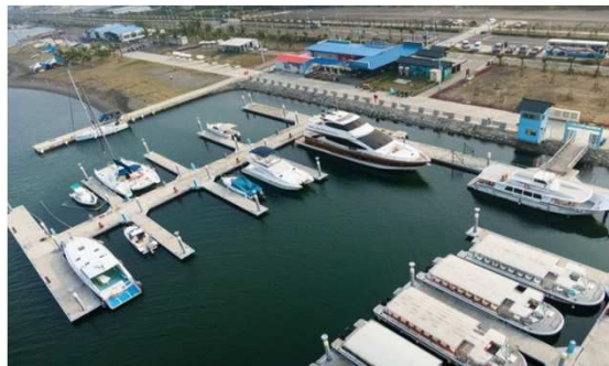
濱灣公園欄杆及管理處扇形 廣場周邊相關設施整建工程
