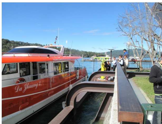
電動船快速充電設施
