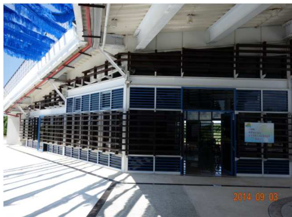
外牆玻璃隔熱改善工程
