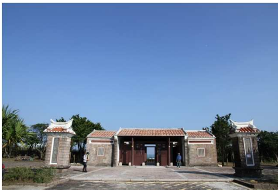
鹽寮公園入口建築
