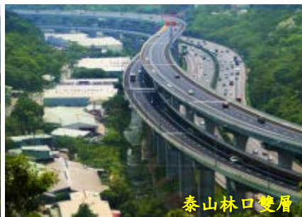
泰山林口雙層橋
